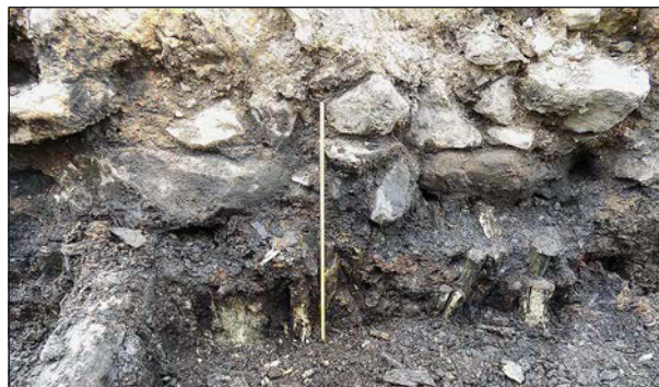
Figur 16. Pålning under fundament i Garvaregränd. Foto från öster.
