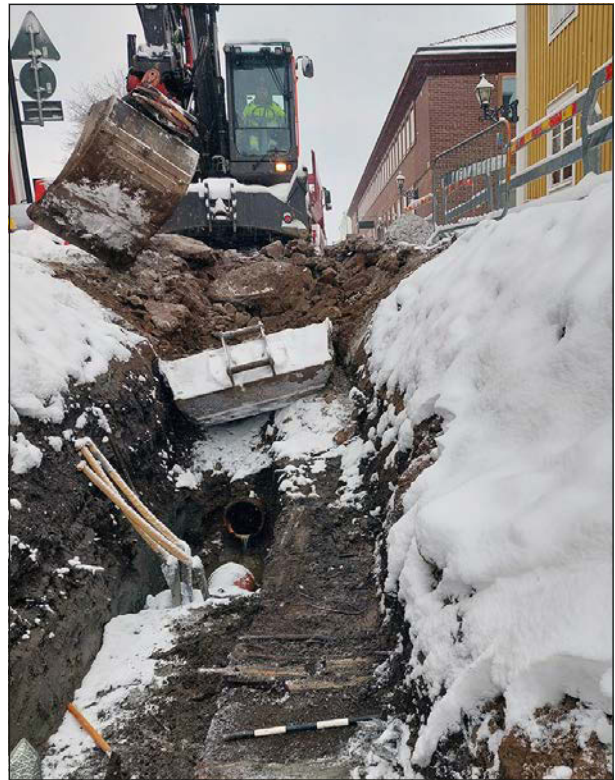
Figur 11. Schaktning vintertid kring Storgatan 26. Foto från öster.
