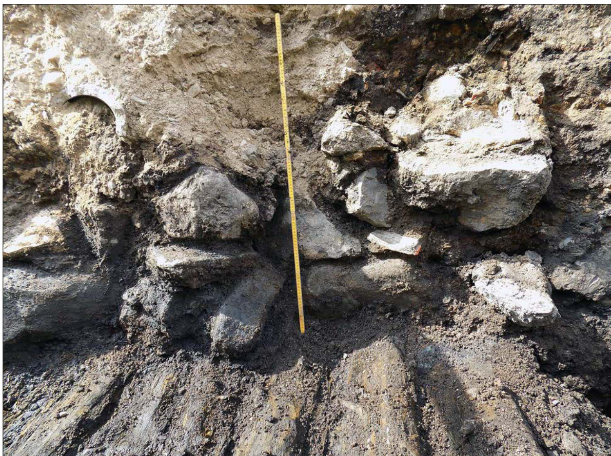
Figur 59. Fundament A4155 med trägolv A4109. Foto från öster.
