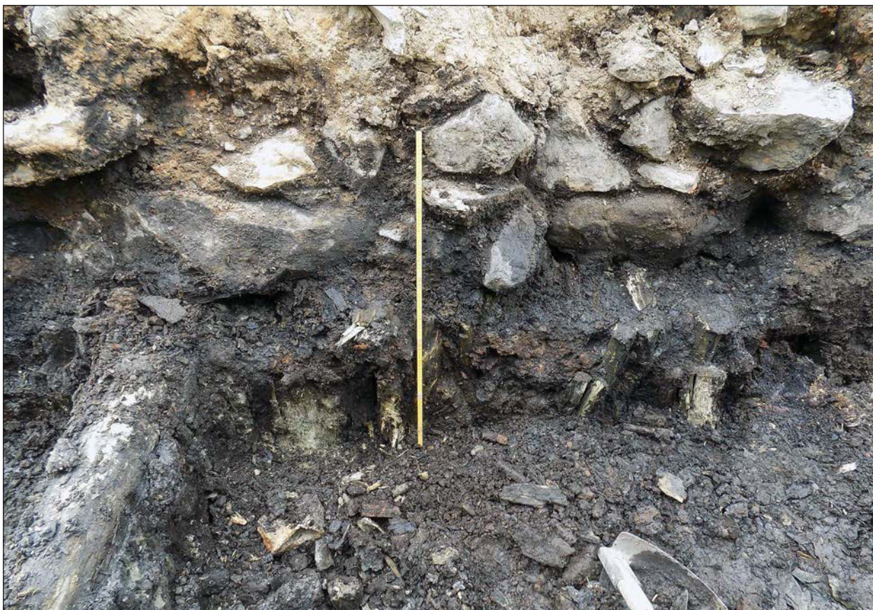
Figur 58. Fundamentet i genomskärning med rustbädd och pålar under. Foto från öster.
