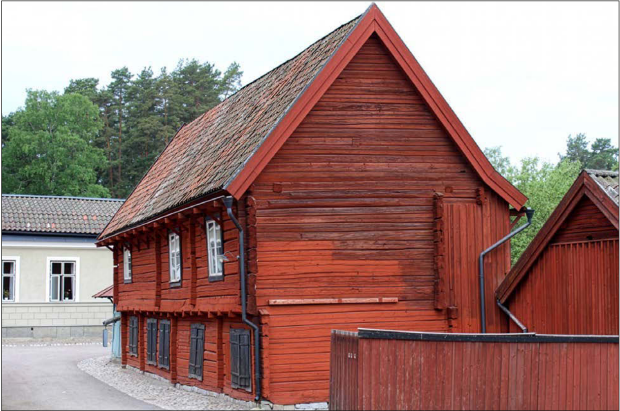
Figur 104. Del av Järnhandlargården från 1600-talet vars ursprung var Smedjegatan i Arboga. Notera bodsluckorna på nedre botten. Foto: Vallby friluftsmuseum.
