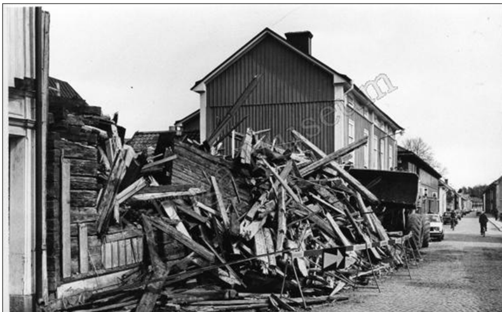
Figur 4. Rivning av bostadshuset ut mot Storgatan. Fototid 1900-tal.
