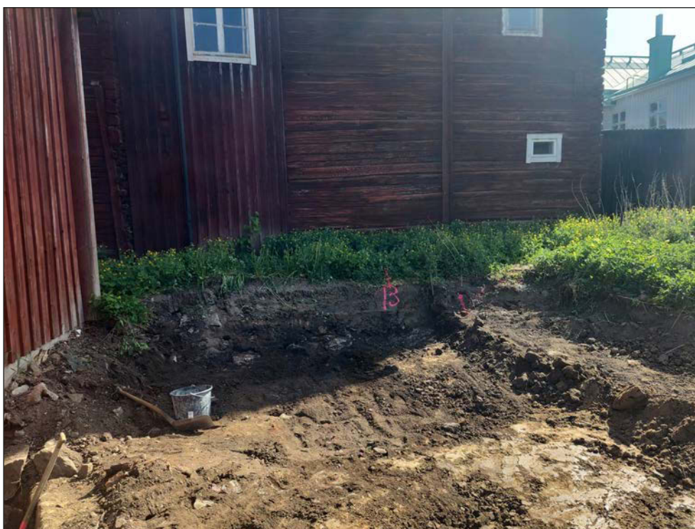
Figur 9. Schakt 1 fotat från väster. Notera stentrappan till vänster i bild och syll A100 i schaktkanten längs upp i bild.
