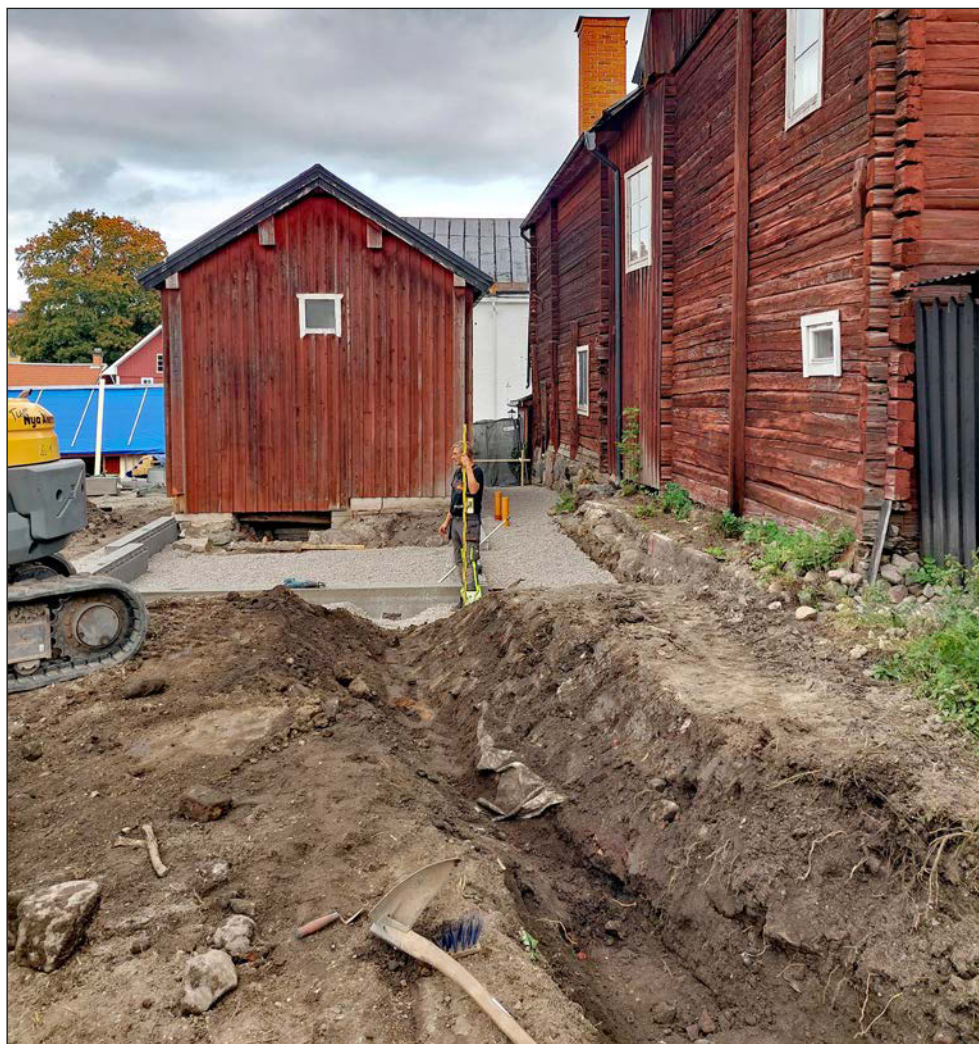
Figur 12. Norra delen av Schakt 3. Notera markduken längs den östra schaktkanten som är del av FU schakt 2. Foto från söder.
