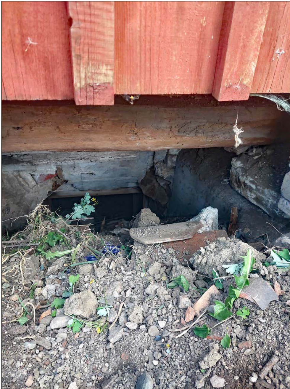
Figur 13. Den igenlagda ingången till källaren innan upprensning. Foto från Söder.
