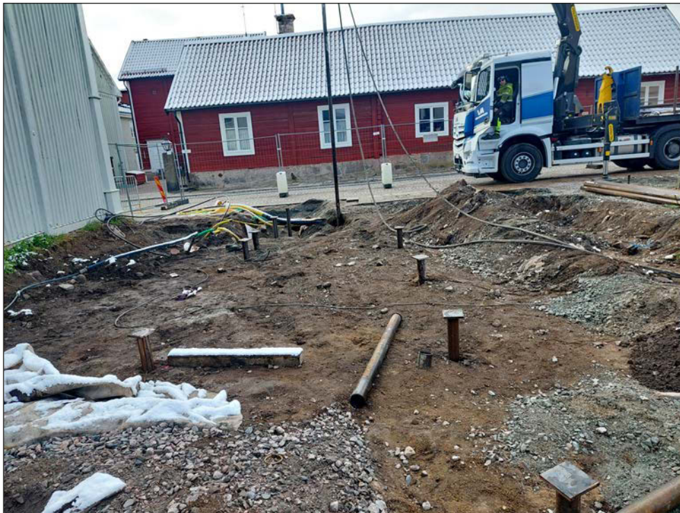
Figur 17. Pålning inför byggnation utmed Storgatan. Foto Från norr.
