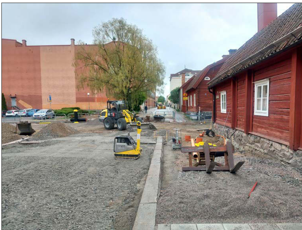
Figur 4. Foto där arbete med ny gatubeläggning pågår på Nygatan. Foto från väst.
