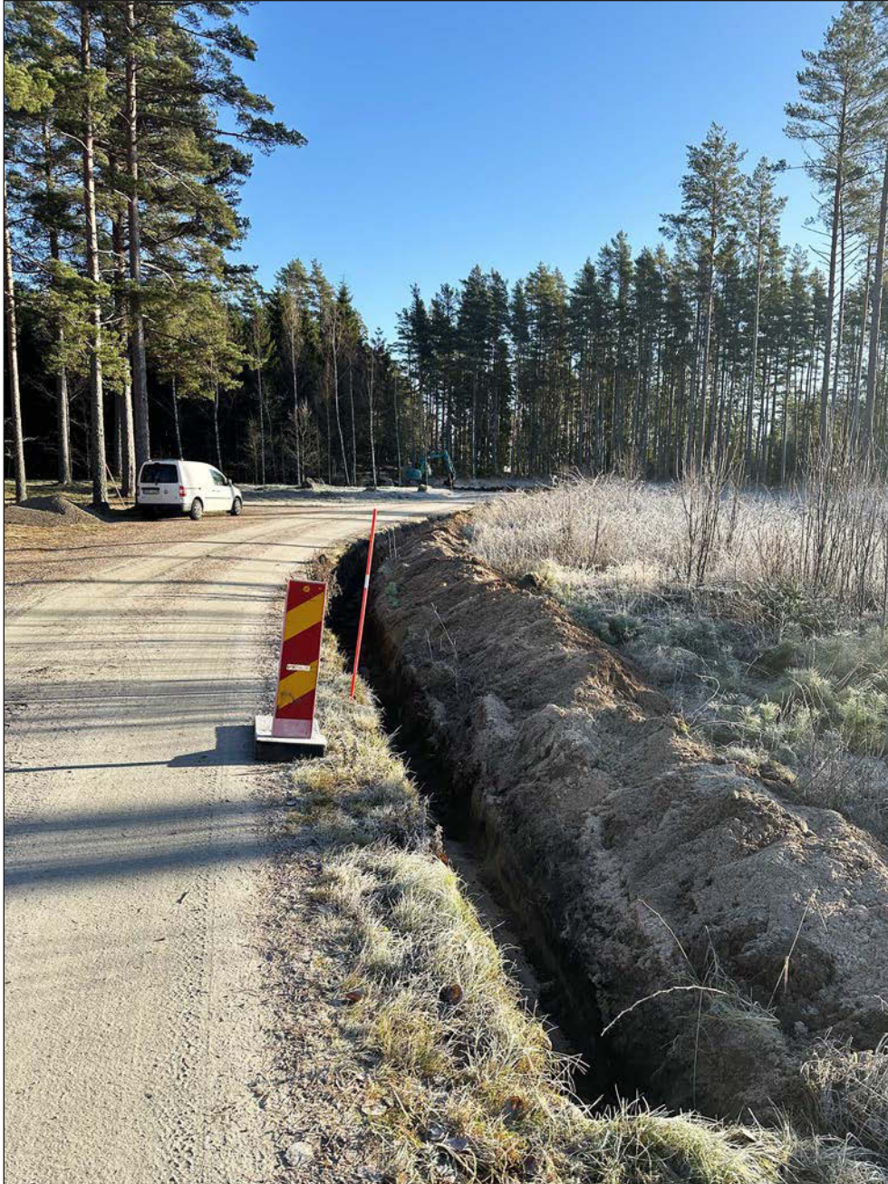
Figur 6. Området efter schaktning. Foton taget från väster.
