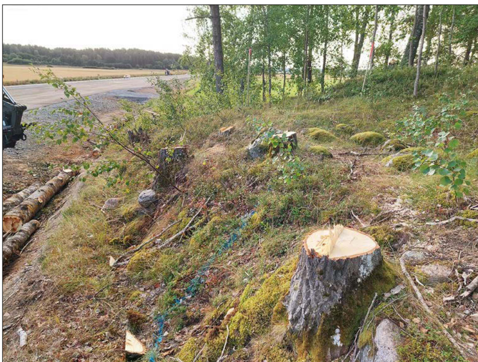
Figur 5. Översiktsbild innan släntarbete påbörjades. På fotot syns det tidigare utförda släntarbetet väl. Här anas även en blåmarkerad linje som anger var släntarbetet skulle göras. Fotot taget från västsydväst.
