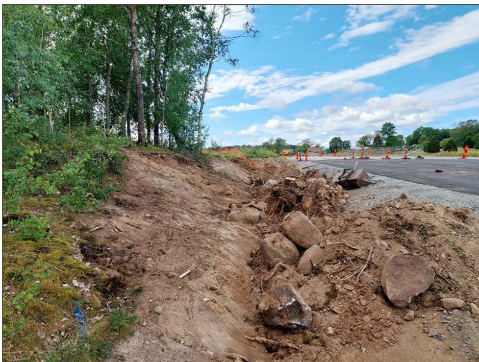
Figur 6. Arbetsbild efter avslutat släntarbete. På fotot syns det påträffade och bortrensade stenmaterialen, liksom de stubbar som togs bort i samband med undersökningen. Fotot taget från ostnordost.
