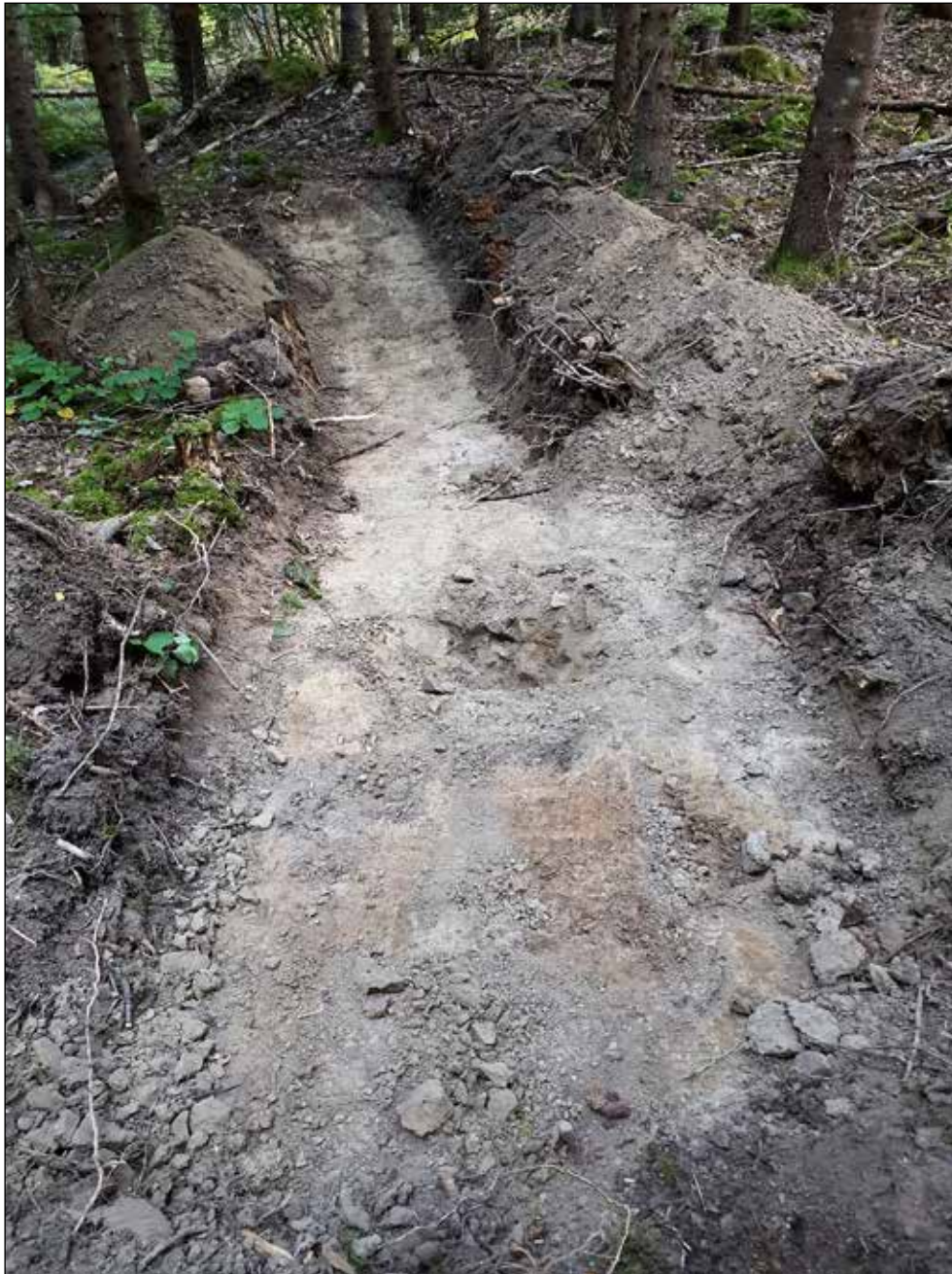
Figur 15. Kokgrop A1243 i schakt 1252 inom arbetsyta nr 142. Foto från söder.
