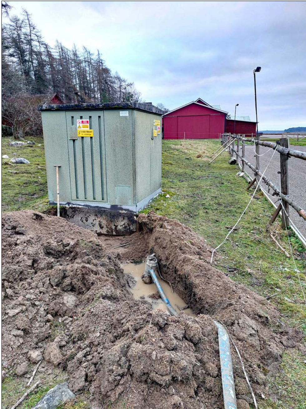
Figur 4. Vattenfyllt schakt fotat från sydväst.
