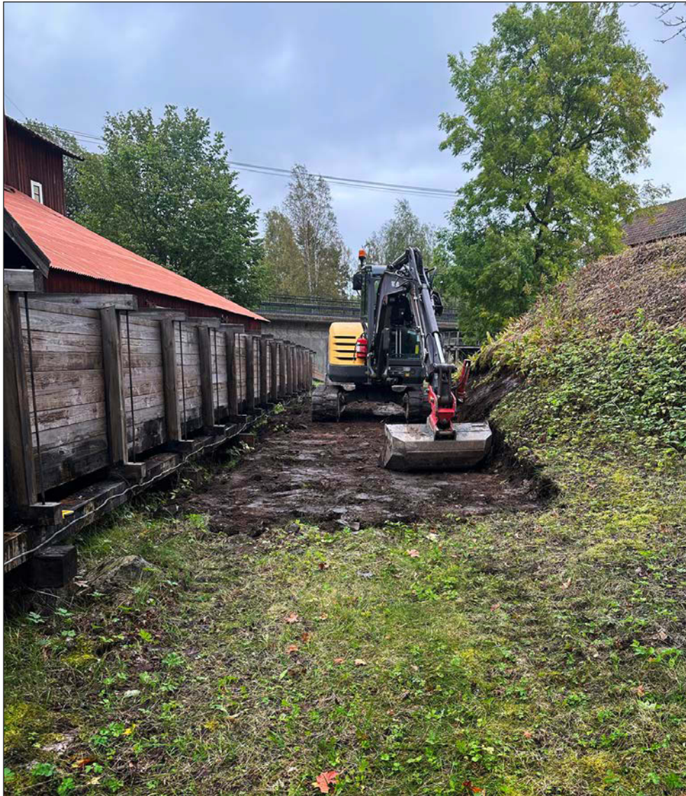
Figur 5. Området efter schaktning. Foto från sydväst.
