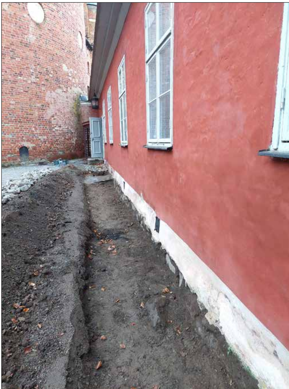
Figur 4 Schaktet fotat från nordöst.
