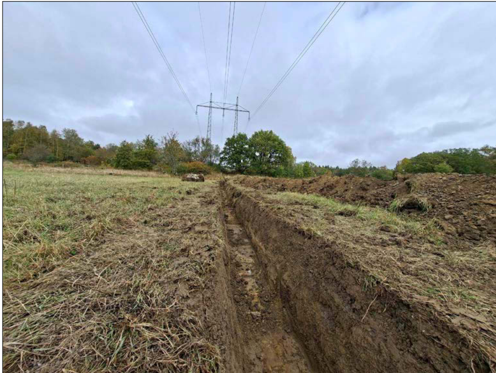
Figur 11. Översiktsbild av schaktet som grävdes vid Ärja. I bakgrunden syns de ledningsstolpar som skulle förses med ny jordlina. Foto från söder.
